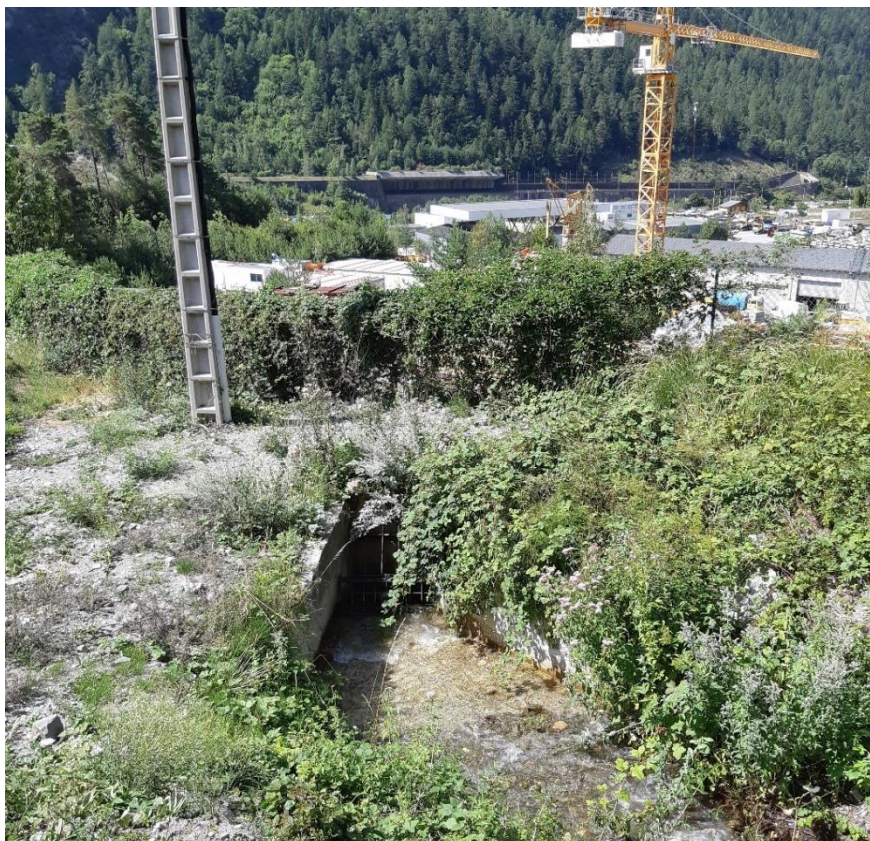
Photographie 3 : Ruisseau de Sainte-Claude à l'est du site - Juillet 2018 (Source : S2iP)
