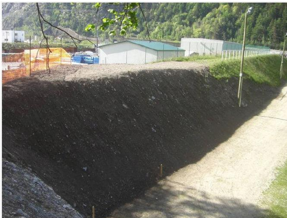
Photographie 2 : Merlon acoustique existant en limite ouest du site (source : S2iP)
