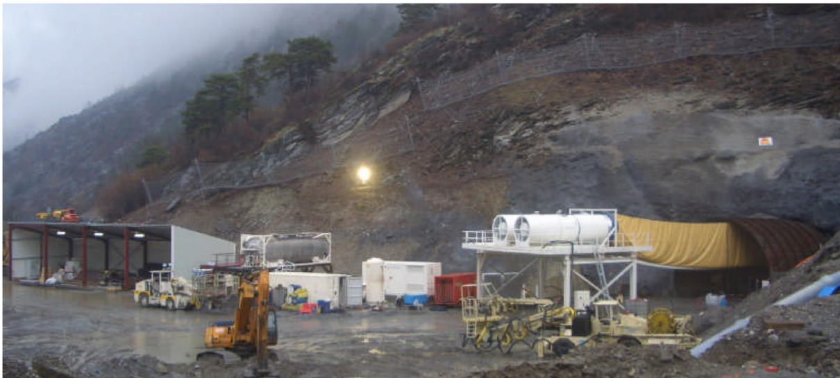
Photographie 4 : Implantation des filets pare-blocs existants
